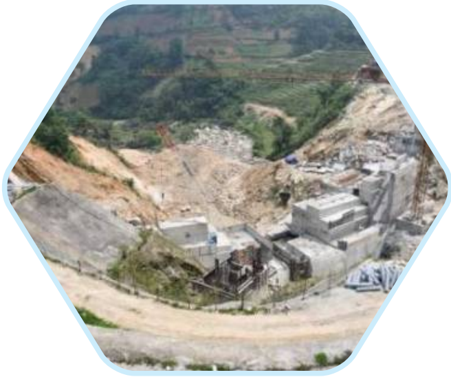
THỦY ĐIỆN NẬM SÀI Tại xã Nậm Sài - Sa Pa - Lào Cai
