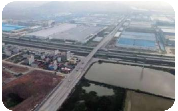
CẦU BẮC GIANG
